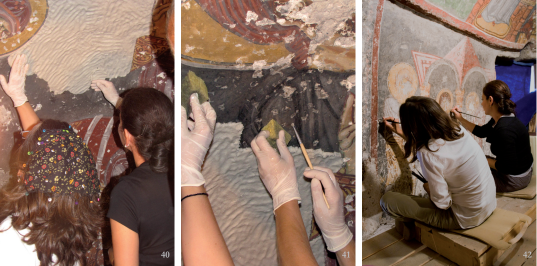
38-39. Al lavoro. La riadesione degli intonaci e la reintegrazione pittorica della volta dei Quaranta Martiri 40-42. La rimozione dell'impacco durante la pulitura e la reintegrazione pittorica della Presentazione al tempio 43-44. La navata nord prima e dopo gli
